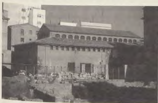
Vista del Almodín antes de su restauración
